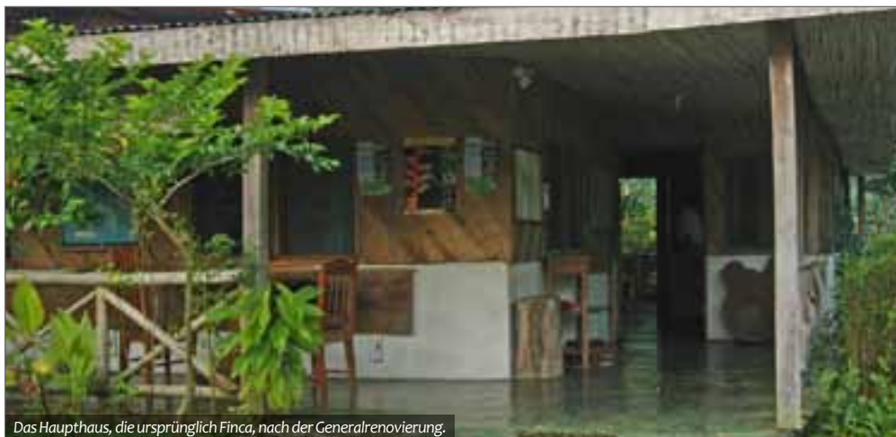
Das Haupthaus, die ursprünglich Finca, nach der Generalrenovierung.
