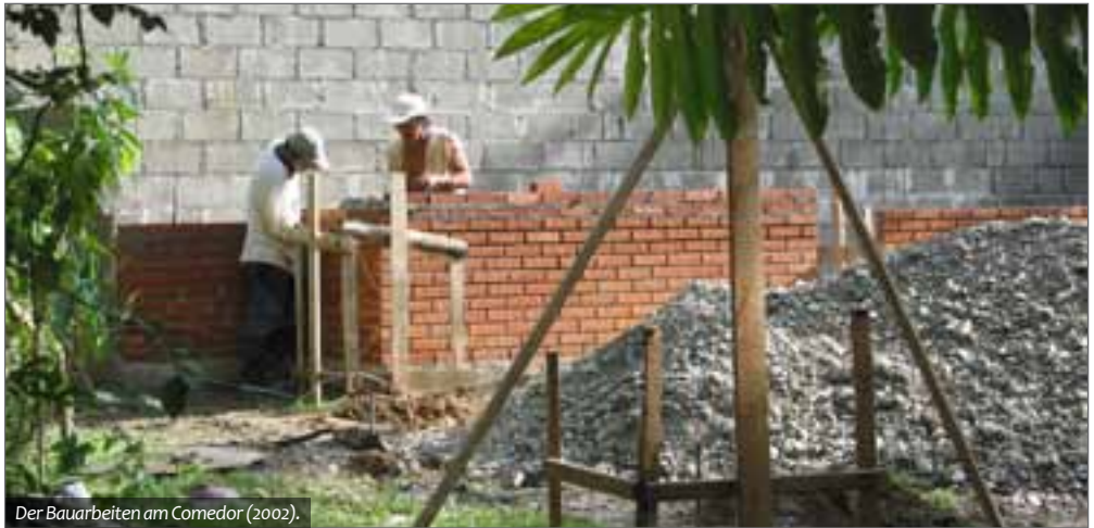
Der Bauarbeiten am Comedor (2002).
